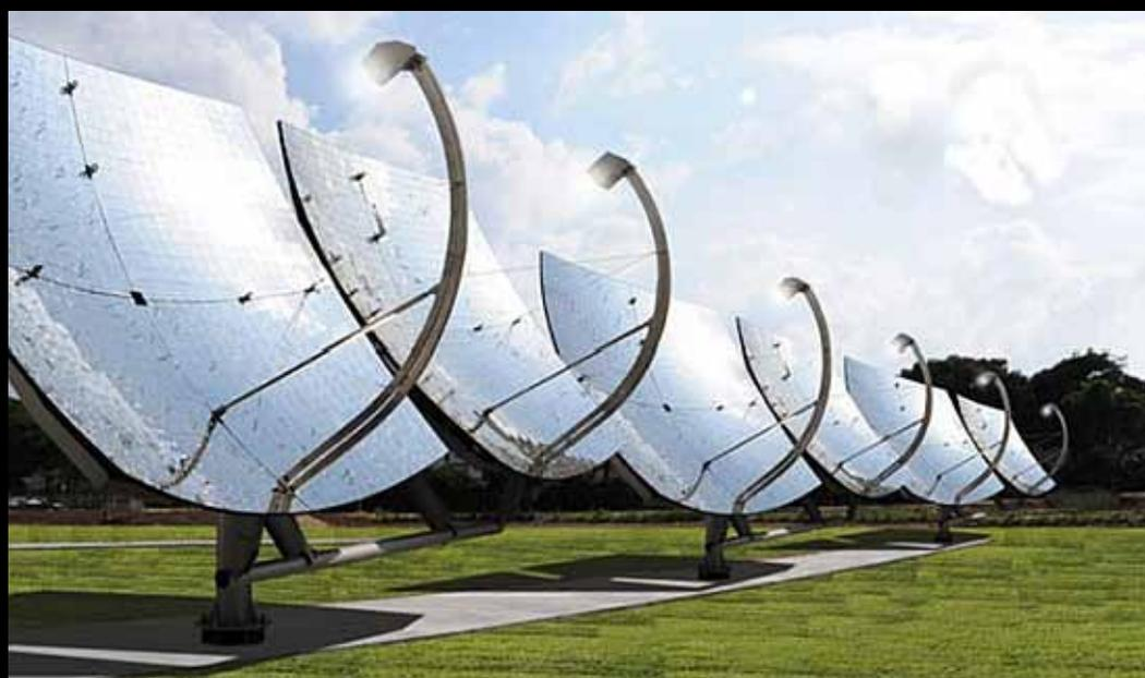
ные общины, а избыток энергии отправляется в национальную сеть. Система побила рекорд эффективности (72%) за счет самой низкой по стоимости энергии и лучшего потенциала для сокращения затрат на энергетические системы. Достигнуть этого рекордного уровня стало возможным с помощью полупараболических оптических зеркал для сбора солнечной энергии.
